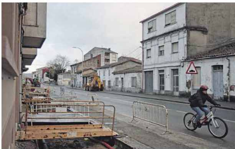
Obras de instalación de la nueva tubería de la red de general de agua a la altura del Morín. CARLOS CORTÉS
